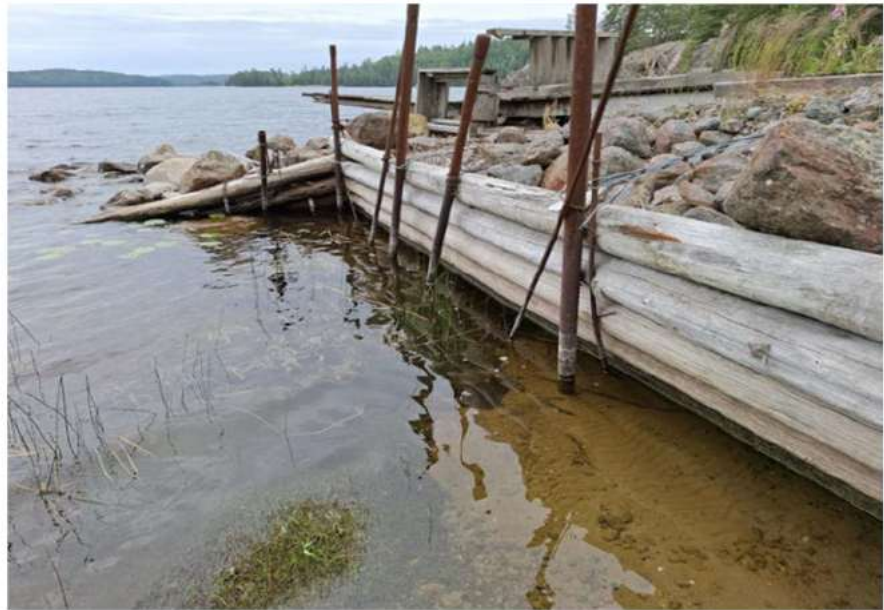
Bild 4. Telestolpar samt järnrör som håller samman piren med vajrar och kedjor.
