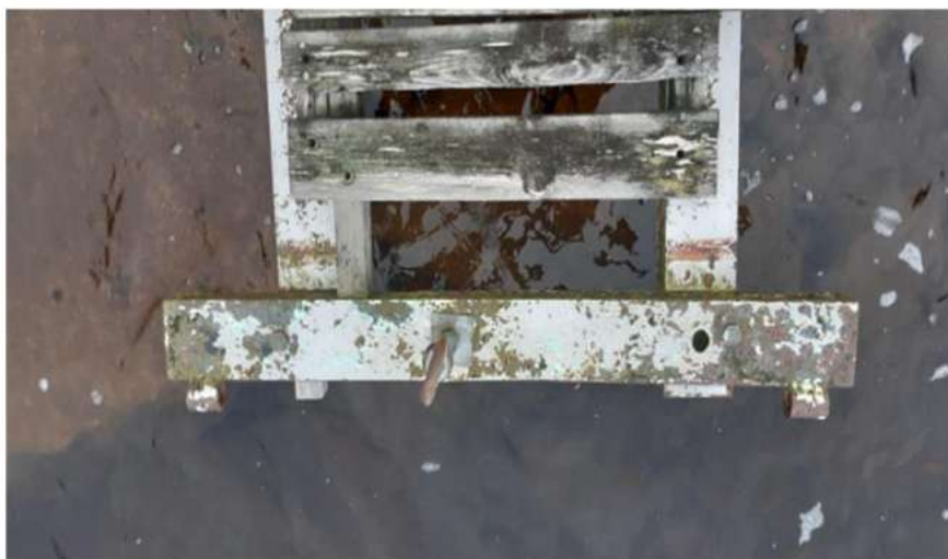
Bild 9. Yttersta delen av bryggan. Stålbalkar med fästeanordning för flytbrygga.
