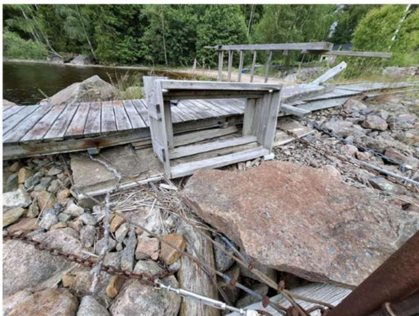
Bild 6. Betongfundament med järnbalkar och brädor.
