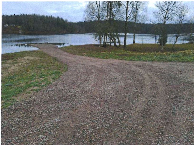
Bild 1. Förstärkt framfartsväg och pirliknande konstruktion
