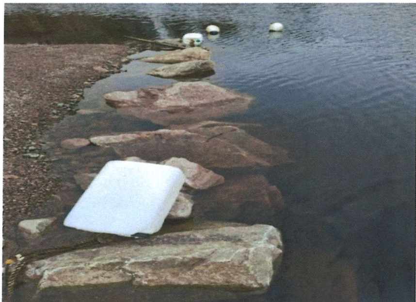
Bild 3. Den pirliknande konstruktionen är anlagd med stenblock och grus.
